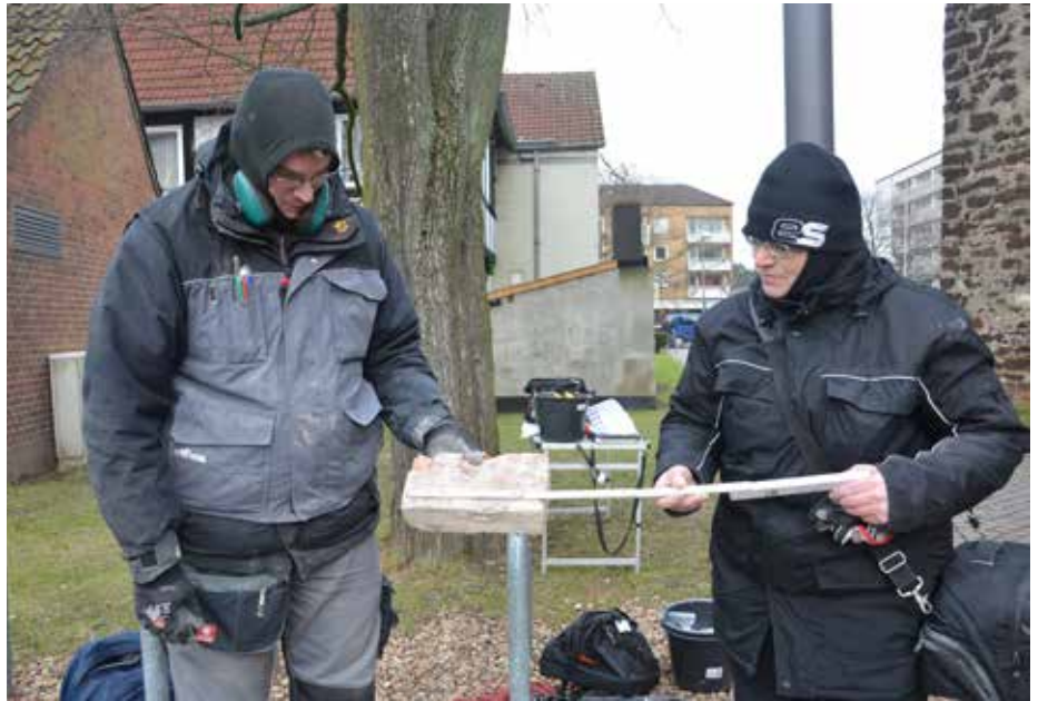
Holger Naumann und Antje Rinne haben Proben des Mauerwerks entnommen, um sie im Labor zu untersuchen. Foto: Andrea Hesse
