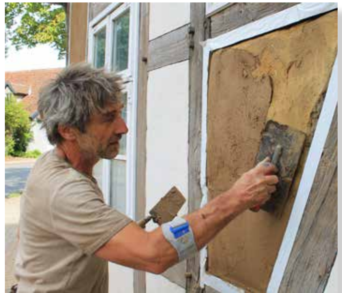
Axel Conrad trägt dem Lehmputz auf den Lehmunterbau in den einzelnen Gefachen auf. Foto: Friedrich Bernstorf
