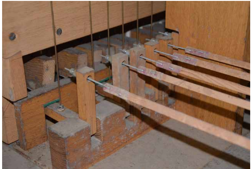
Eine Schicht aus Staub und Schimmel hat sich im Innern der Bissendorfer Orgel an vielen Stellen abgesetzt. Foto: Andrea Hesse
