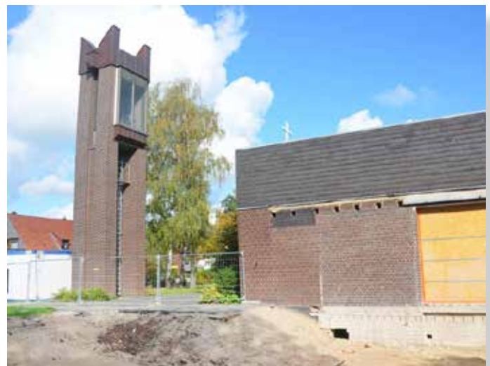
Ort der Grundsteinlegung: die Baugrube vor der Christophoruskirche.
