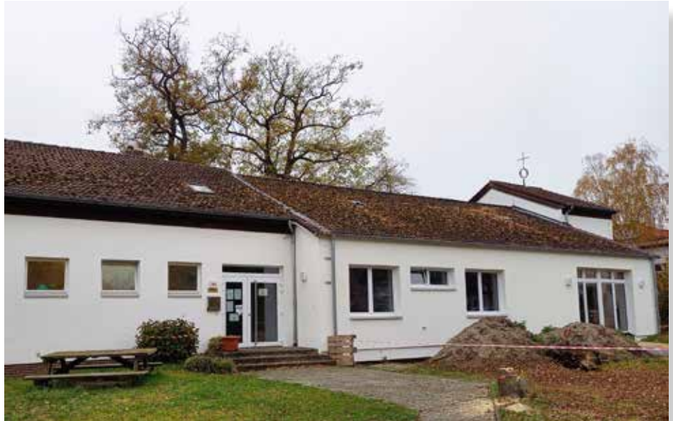
In der Kapernaumkirche in Resse sind die Umbauarbeiten abgeschlossen.
