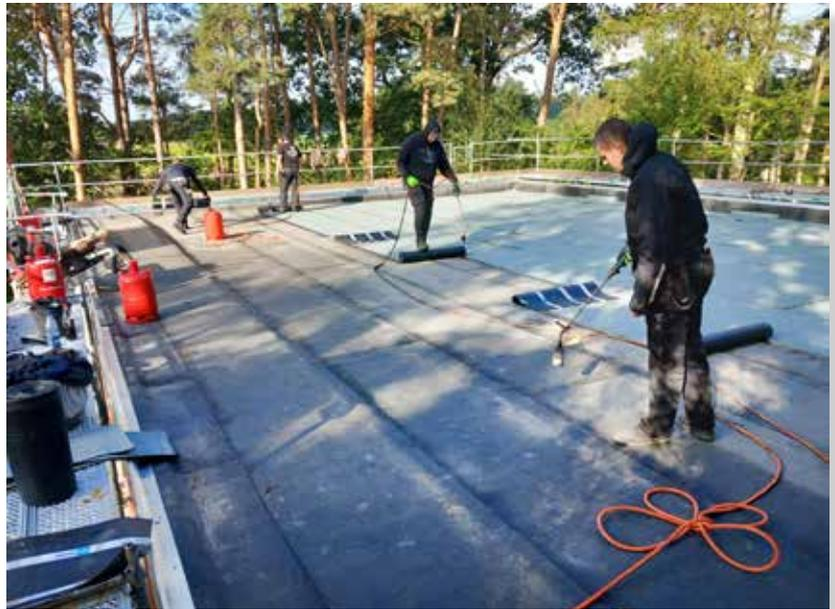
*Die Reparaturarbeiten sind fast abgeschlossen; die letzte Schweißbahn wird heiß verklebt. Foto: Friedrich Bernstorf*
