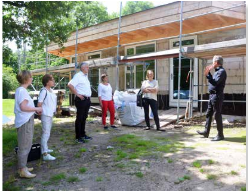
Baustellenbesichtigung: Tabea Pipenbrink (von links), Kirchenvorsteherin Sigrid Neumann, Bürgermeister Mirko Heuer, Bettina Praßler-Kröncke und Sozialdezernentin Eva Bender mit Architekt Christian Kardaß. Foto: Andrea Hesse
